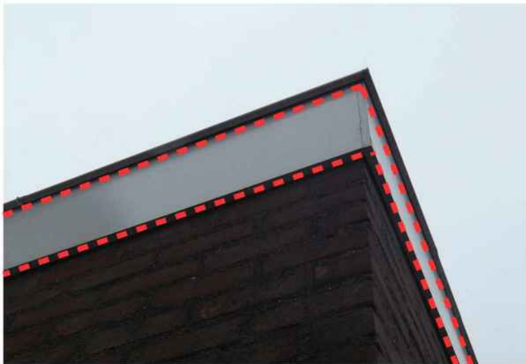
detail dakrand; niet toegankelijk voor vleermuizen
